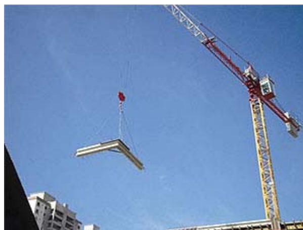
Obra da Tecnisa com grua e pré-moldado. A empresa vem ampliando a atuação com central de pré-moldado em canteiro
