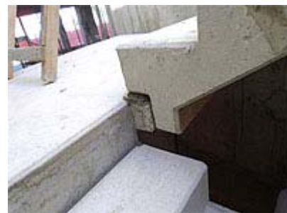
Detalhe de encaixe de escada pré-moldada: precisão é fundamental
